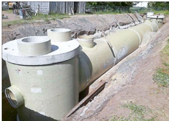
Unter der Parkanlage zwischen der „Wiesenstraße“ und dem „Kreuzweg“ ist ein 19 Meter langer Stauraumkanal entstanden.
