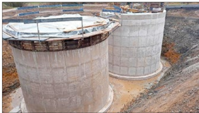
Vorklärbecken und Schlammager der Kläranlage Klings
